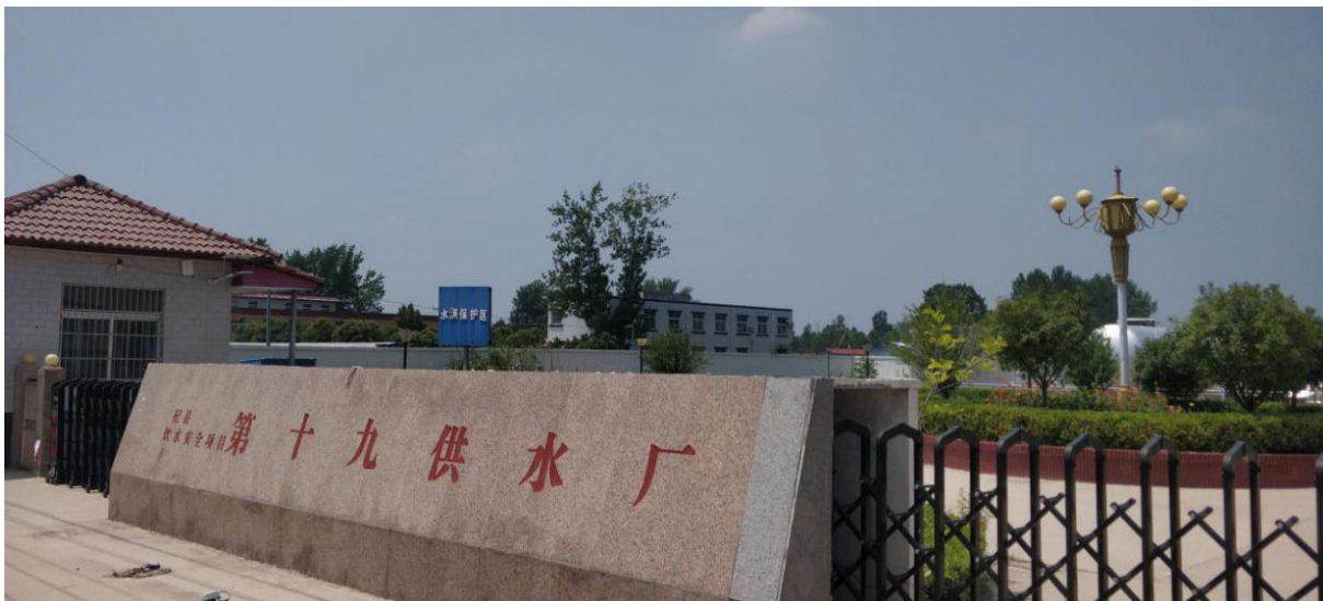
图2.8.1-3 杞县第十九供水厂现状面貌
